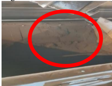
Gambar 2. 1 Permasalahan yang terjadi pada Inlet Chute
