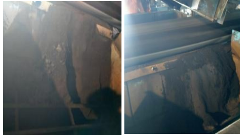
Gambar 2. 3 Penumpukan material batu bara pada inlet chute
